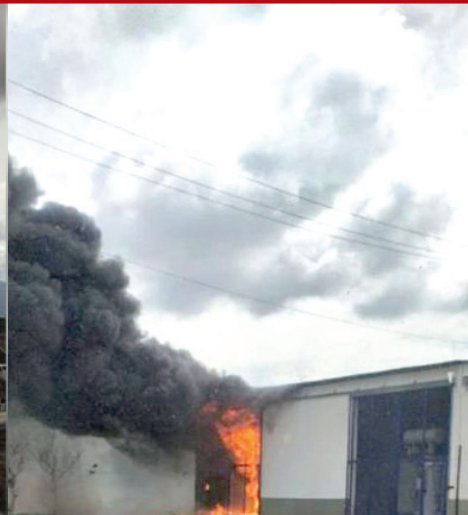
Incêndio na subestação de Goiabeiras acontece três dias após o governo retirar R$ 8 bilhões do MEC
