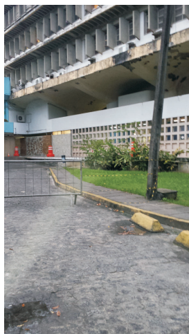
Área externa - Entrada da Portaria 1 do HC interdita por risco de vida pela queda de pedaços de concreto e armação de ferro - fachada em frente ao Banco
