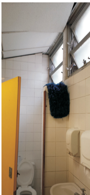
Térreo - Banheiro dos funcionários, próximo à Portaria 4
