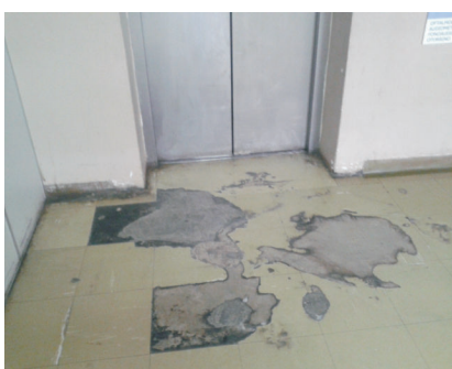
Piso em frente ao elevador
