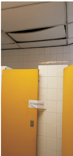
Térreo - Banheiro dos funcionários, próximo à Portaria 4 - 1
