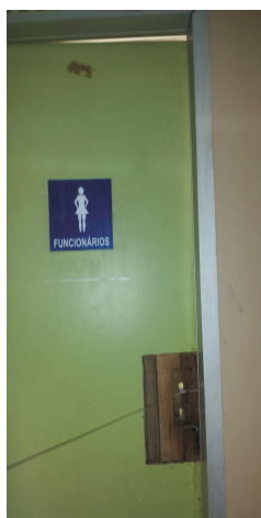
Enfermaria de Psiquiatria - 7º Andar - Banheiro de funcionários com elástico como tranca
